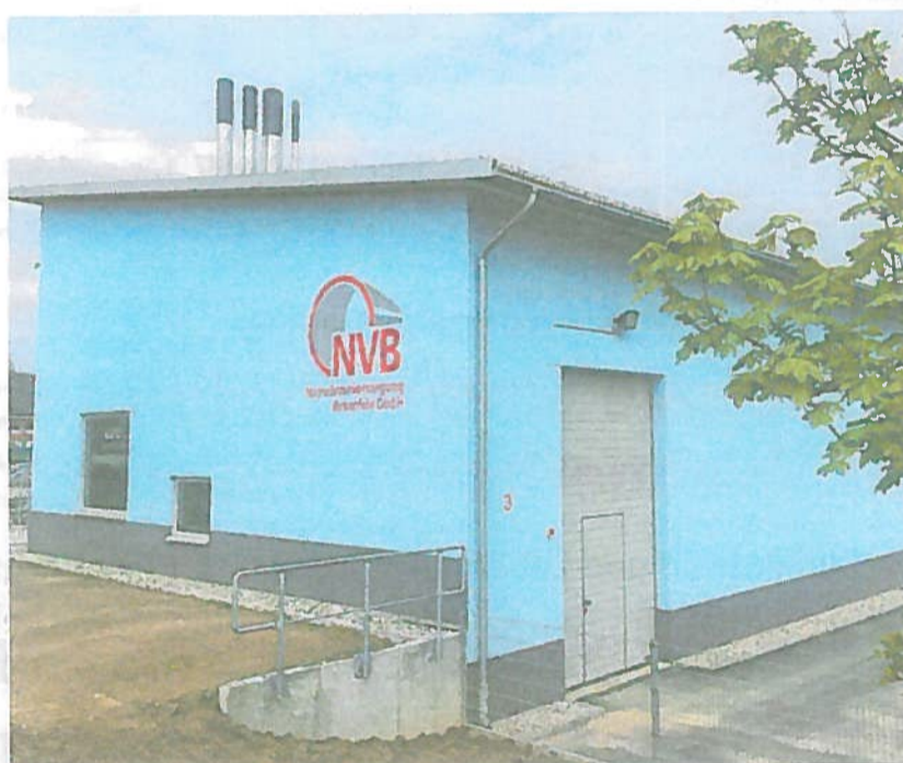
Heizzentrale Nahwärmeversorgung Birkenfeld
